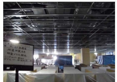
天井施工状況
