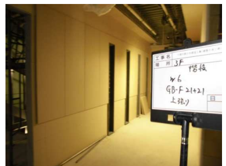
間仕切壁工事
