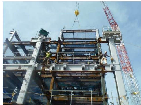
鉄骨取付の状況
